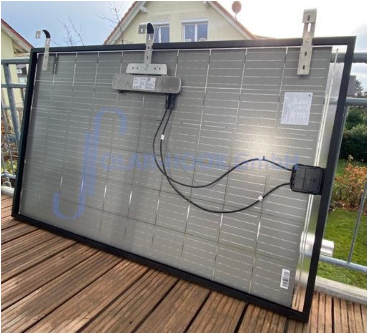
Abb.9/vorbereitetes Solarmodul mit 3 Befestigungsbügeln und Wechselrichter
