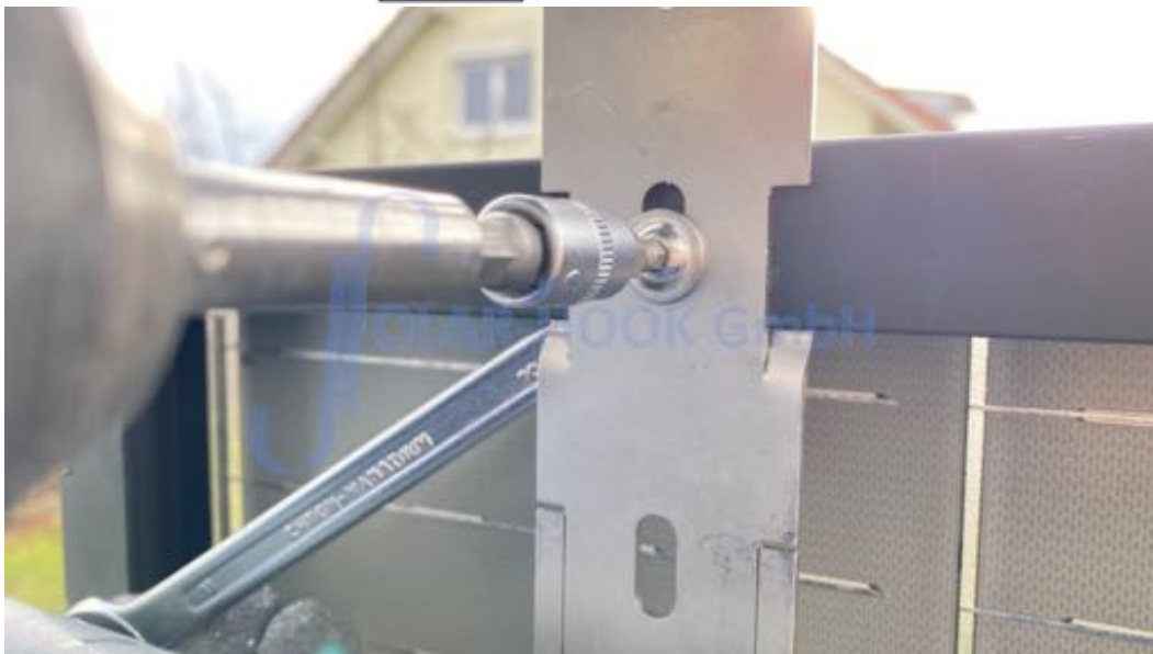
Abb. 18/Anziehen der kurzen Schrauben
